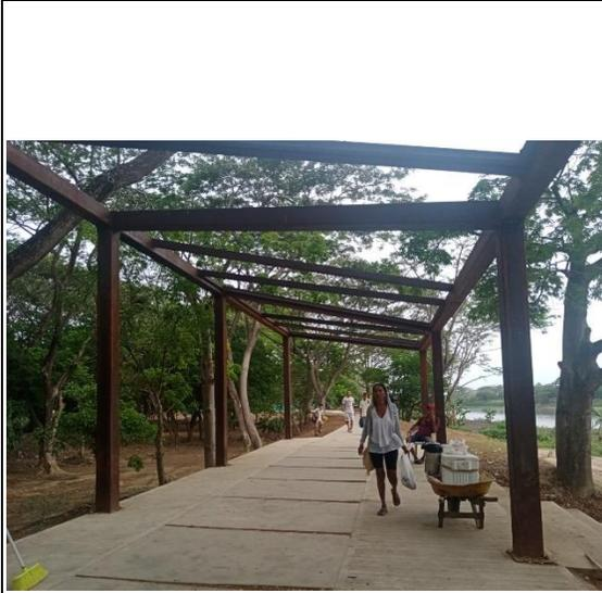
Fotografía No. 1. Vista general de la estructura metálica portal de sombras del ítem 3.04.01, no tiene la pintura de protección de acuerdo con las especificaciones del ítem, se evidencia corrosión en la estructura existente.
