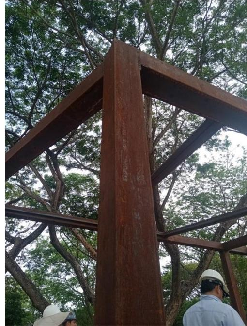
Fotografía No.2. Vista de detalle de estructura metálica portal de sombras del ítem 3.04.01, no tiene la pintura de protección de acuerdo con las especificaciones del ítem, se evidencia corrosión en la estructura existente.
