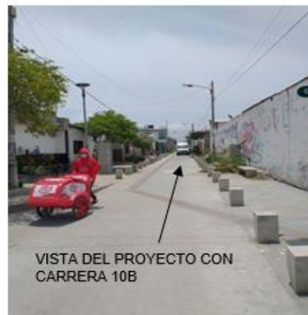
Fuente: Visita de obra CGR del 6 al 8 abril de 2021
