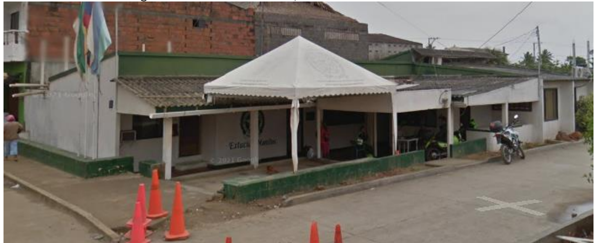
Figura 5 Estación de Policía, Moñitos - Córdoba
